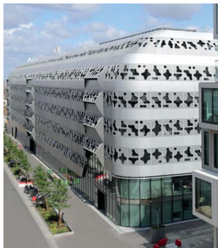
IM BEREICH AUSSENARCHITEKTUR Rézo-Komplex in Paris / Frankreich Architectures Anne Démians
